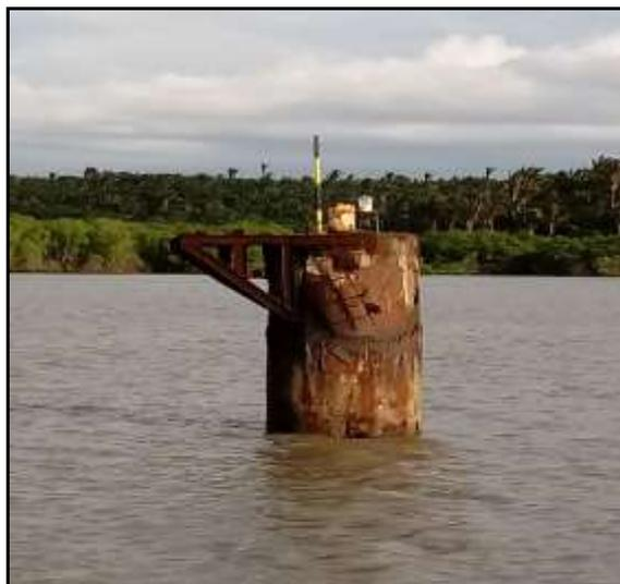
Figura 4: Tubulão nº 1, onde fica uma das lanternas de sinalização náutica, localizado nas proximidades do Terminal do Cujupe.
