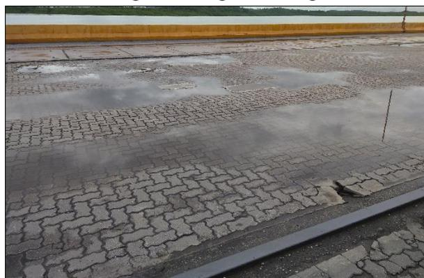
Figura 4: Recalque e acúmulo de água pluvial.
