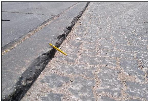
Figura 1: Recalque no Berço    Figura 2: Recalque no berço 100
