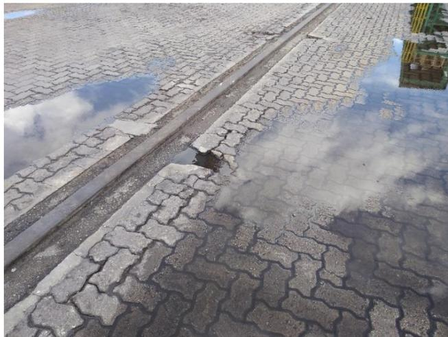
Figura 6: Drenos obstruídos (área central)
