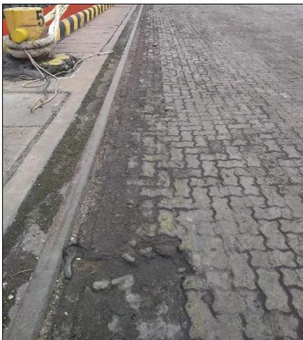
Figura 5: Drenos obstruídos e danificados (Linha de berço)
